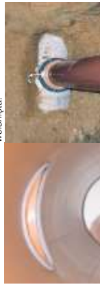
Wkładka jest ustawiona. Uszczelka jeszcze nie wciśnięta.
